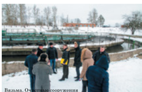
Вязьма. Очистные сооружения
